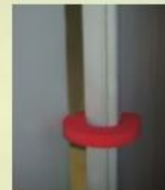
Uksestopper, mis takistab ukse täielikult kinni kukkuda
